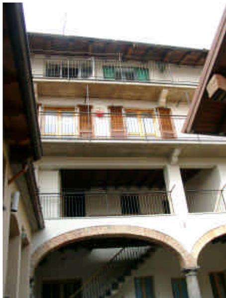
La coerenza dei segni che compongono l'identità di un edificio riguarda molti aspetti. Tra questi quello delle tecnologie strutturali occupa uno spazio molto importante. Spesso si trovano esempi di ballatoi che dall'originaria versione a struttura lignea sono stati rifatti con solette in cemento armato. Ciò, nella gran parte dei casi, altera profondamente il carattere dell'edificio e la sua identità complessiva.
